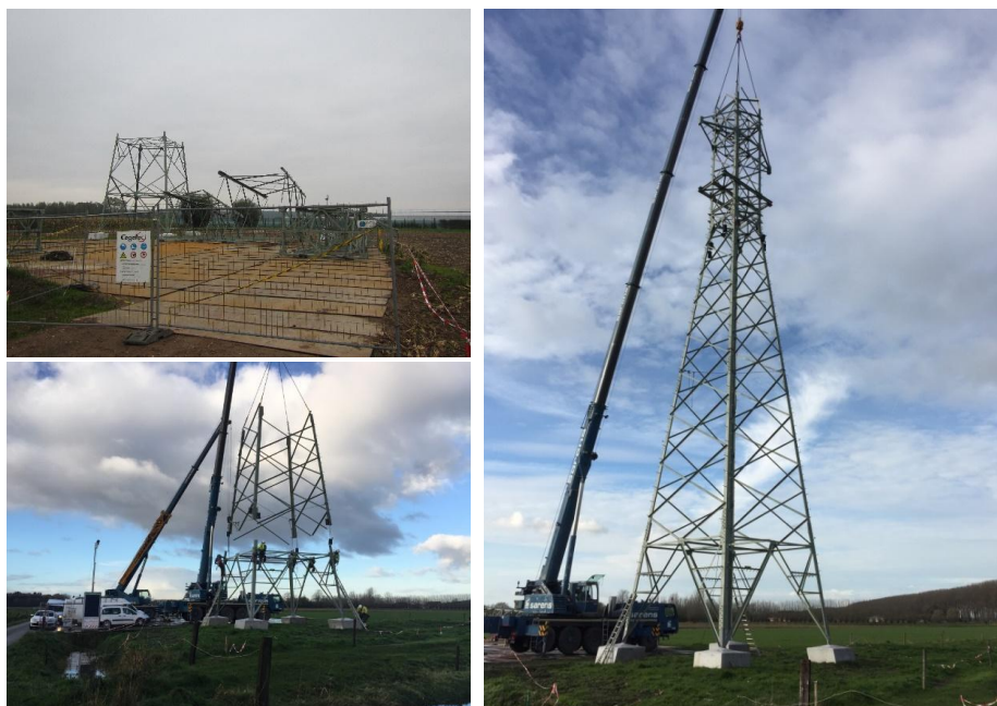
Figure 3 : Assemblage et montage d'un pylône treillis (source : Elia)
