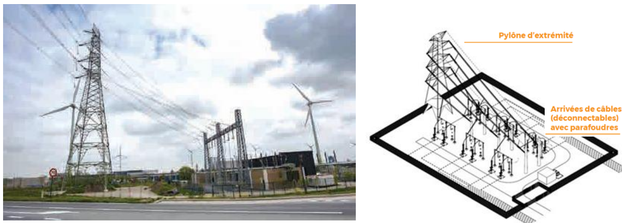
Figure 8 : Poste de transition aérien / souterrain (Source : Etude technologique, Elia, février 2019)
