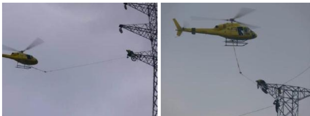
Figure 16 : Installation de la corde dans les poulies de tirage par hélicoptère (source : Elia)
