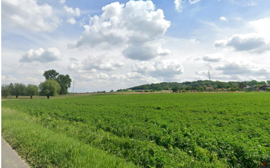
Figure 12 : Vue de la ligne 150 kV existante dans le PIP depuis la rue Deflière (source : google street view) Les enjeux en termes paysagers ne semblent donc pas justifier un enfouissement dans cette zone.
