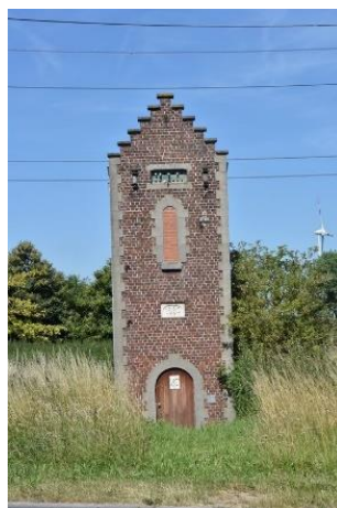
Figure 9 : cabine électrique de la rue Deflière reprise à l'inventaire IPIC
