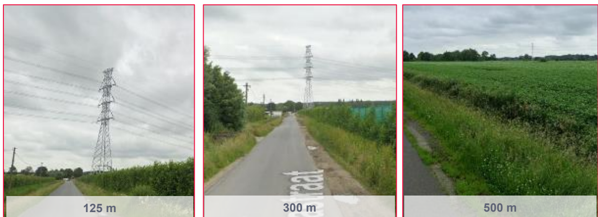
Figure 170 : Variation de la présence visuelle d'un pylône (treillis compact) d'une ligne 380 kV suivant la distance avec celui-ci (source : Google Maps)
