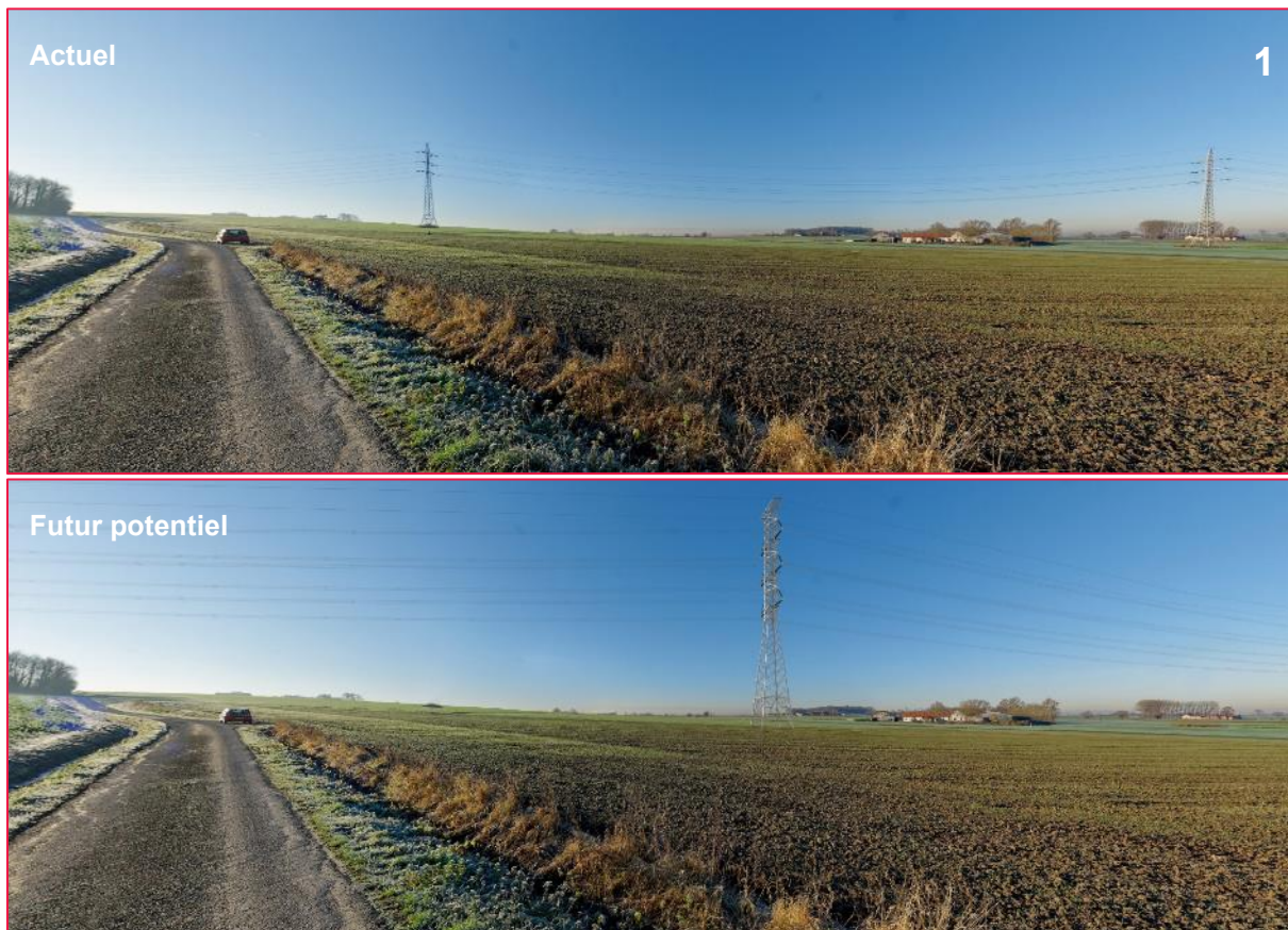
Figure 222 : Insertion paysagère à Frasnes-lez-Anvaing (tronçon II), à environ 150 m de la potentielle ligne côté est (source : Elia)
