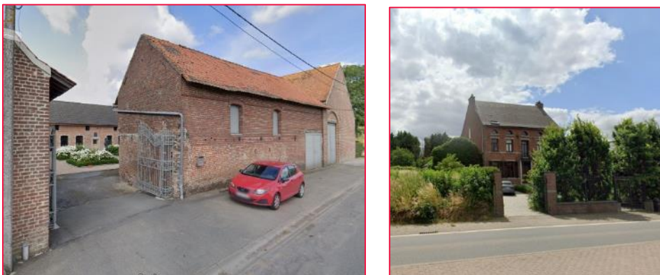
Figure 55 : Ferme en carré et maison de maître reprise à l'IPIC
