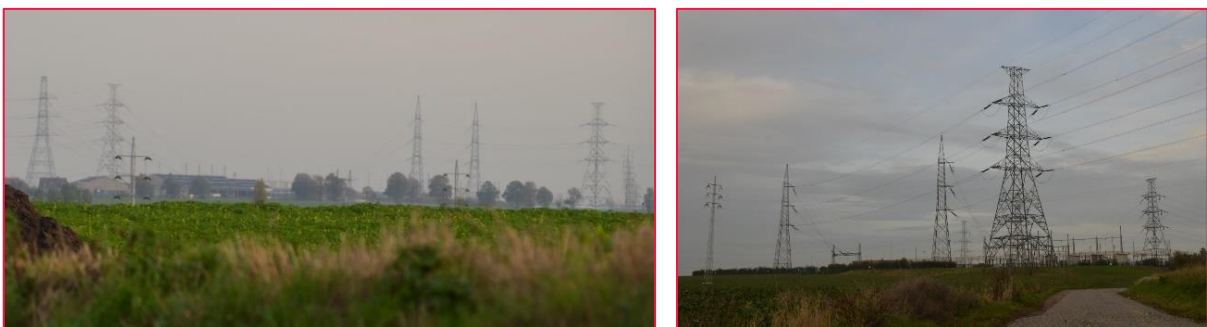
Figure 220 : Poste de Courcelles vu depuis des perspectives lointaines (depuis le nord) et proche (depuis le sud) (sources : Stratec, Google Maps)
