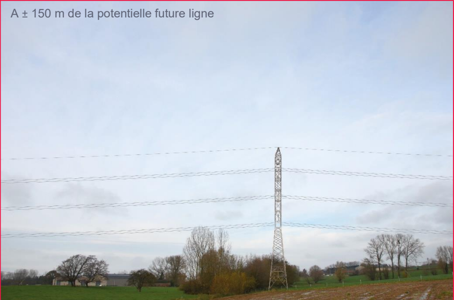
Figure 328 : Vue-type du paysage à environ 150 et 300 m de distance d'un potentiel pylône (source : Stratec, novembre 2023)
