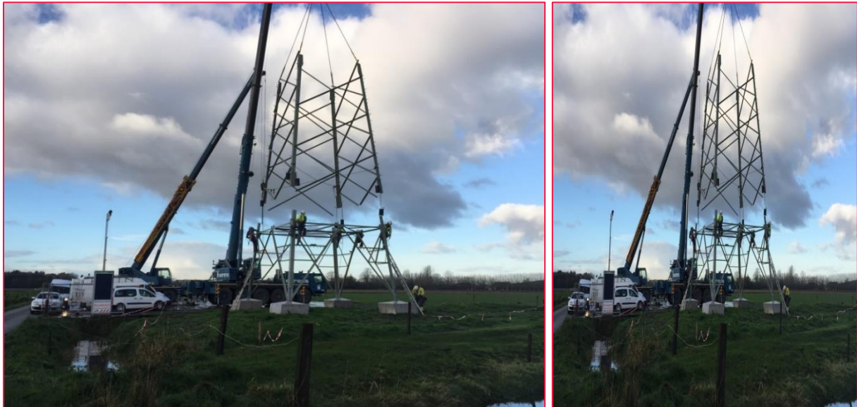
Figure 156 : Exemple d'une grue de levage soutenant un pylône en cours de construction (source : Elia)
