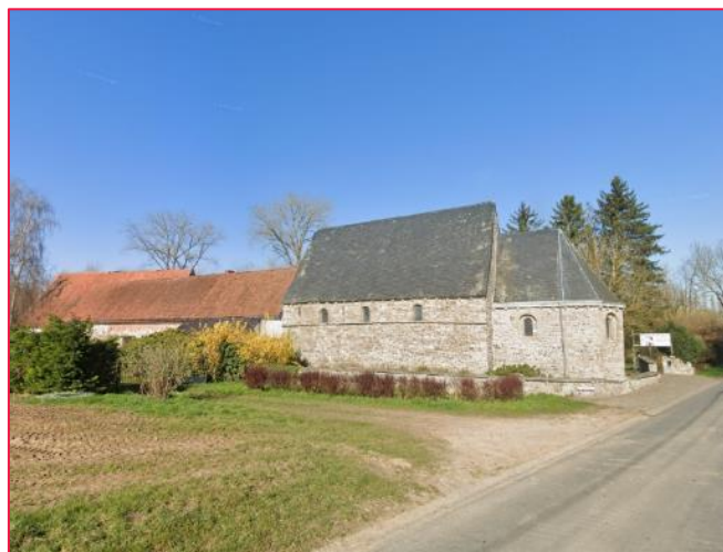
Figure 62 : Chapelle de la Ladrerie (source : Google Street View)
