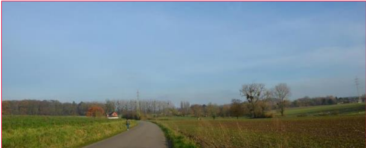
Figure 340 : PIP dans le tronçon 32 – chaussée de Marche (source : Stratec, novembre 2023)
