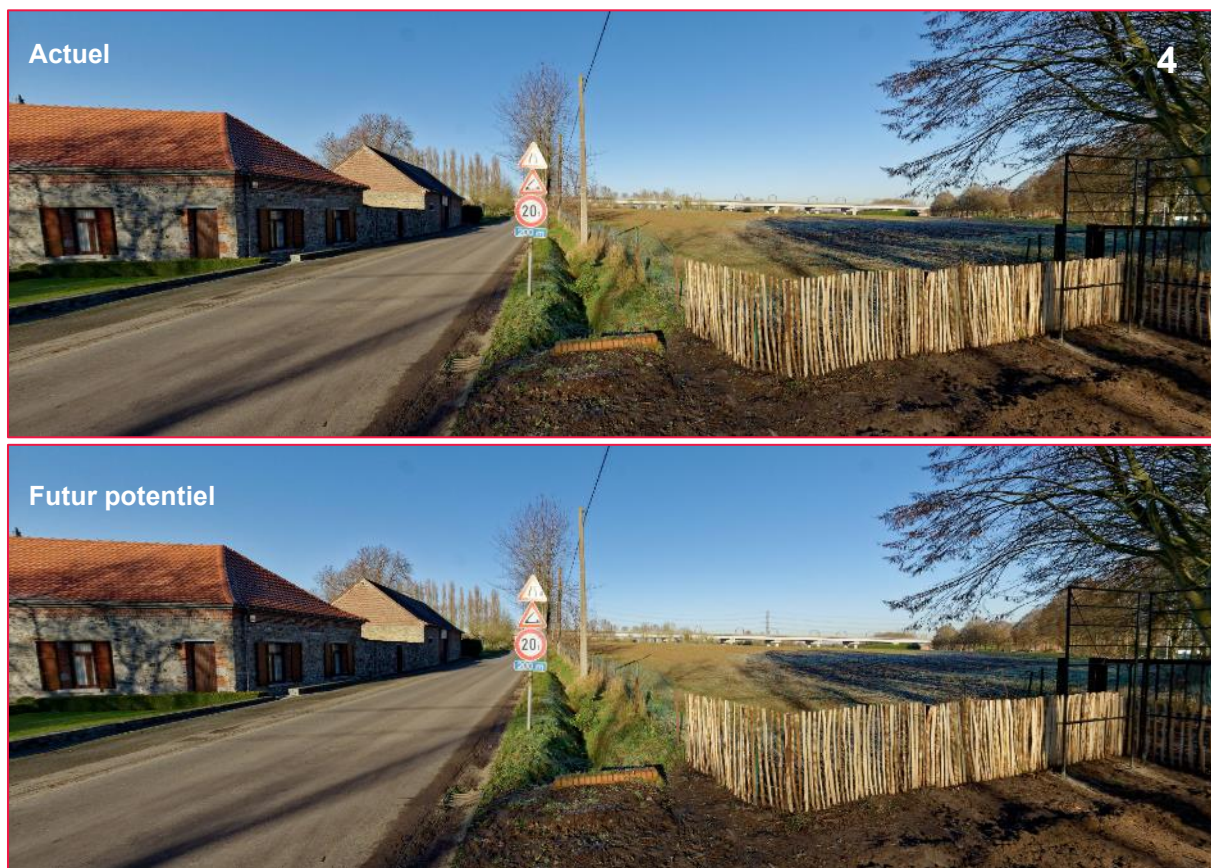
Figure 225 : Insertion paysagère à Chièvres (tronçon V), à environ 200 m de la potentielle ligne côté sud (source : Elia)
