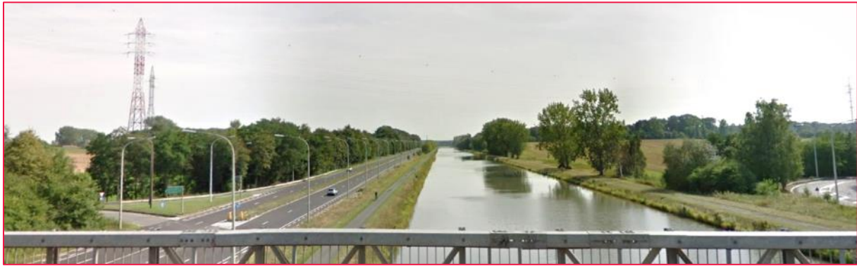
Figure 212 : Vue sur la voie d'eau depuis la E19 (source : Google Maps)
