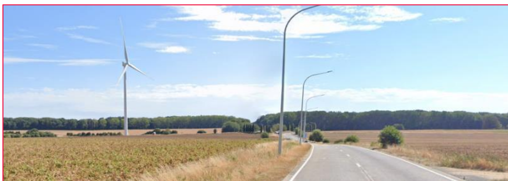
Figure 97 : Paysage du tronçon 23 avec le bois de Courrière en arrière-plan (source : Google Street View)
