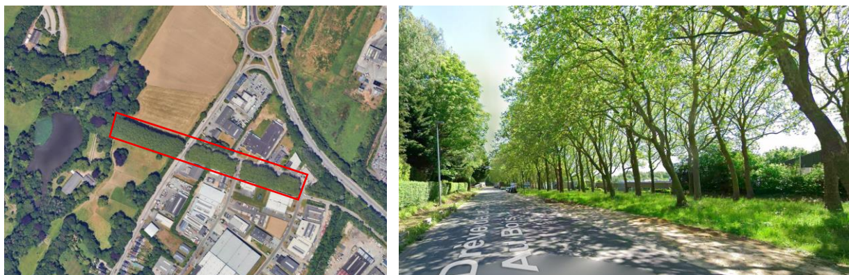
Figure 365 : Alignements d'arbres bordants l'entrée du château de PELLE et prolongation le long de la Drève de la Courte au Bois (source : Google map)
