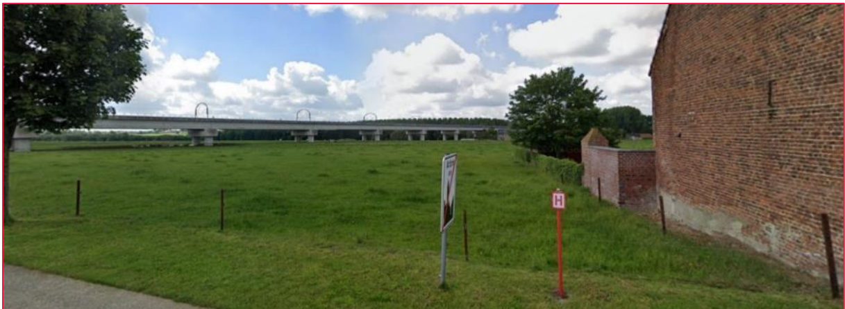
Figure 195 : Viaduc présent au sud du village d'Arbre, derrière lequel pourra être mis en place la ligne haute tension (source : Google Maps)
