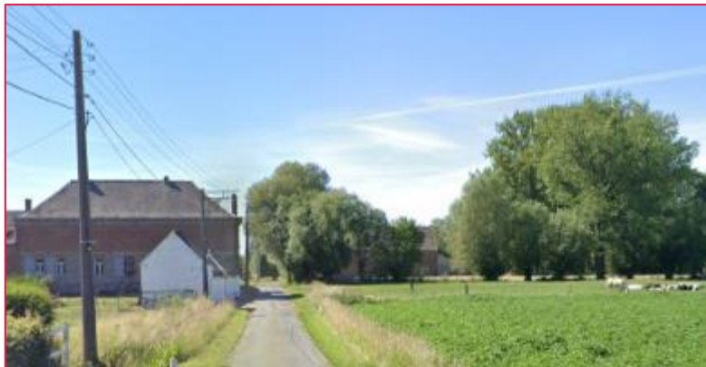
Figure 91 : PIP traversé par le tronçon 21 (source : Google Street View)
