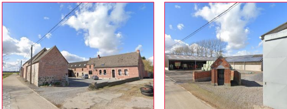
Figure 76 : Ferme du moulin et chapelle adjacente
