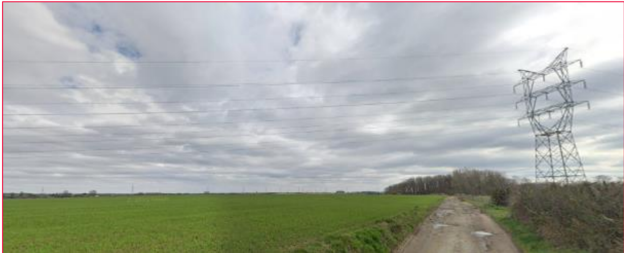
Figure 362 : PIP dans le tronçon 39 – rue de Bernimont (source : Google Street View)
