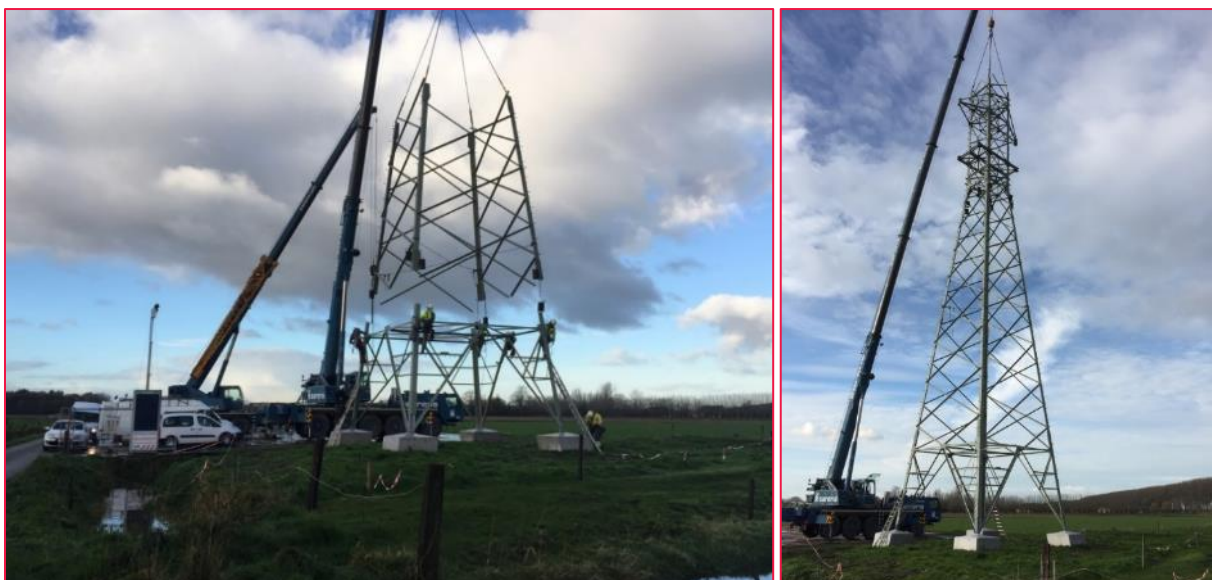
Figure 16 : Exemple d'une grue de levage soutenant un pylône en cours de construction (source : Elia)
