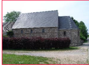
Figure 27 : Chapelle de la Ladrerie à Chièvres (source : Wikipédia)
