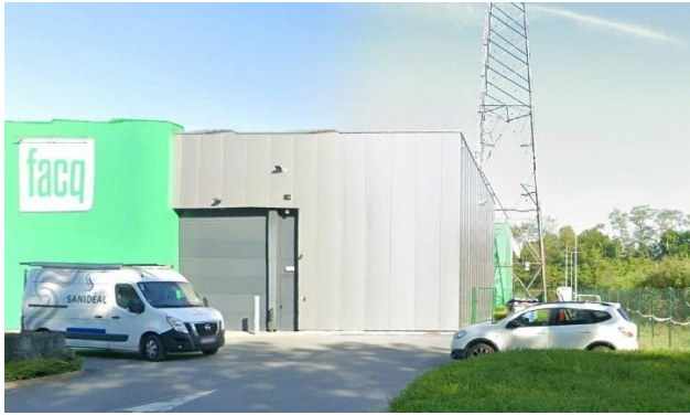
Ligne 150 kV Baudour-Obourg (Pylône 10) : L'entrepôt a été construit en « contournant » le pylône P10. Il en résulte une impossibilité technique de reconstruire ce pylône d'angle en lieu et place.
