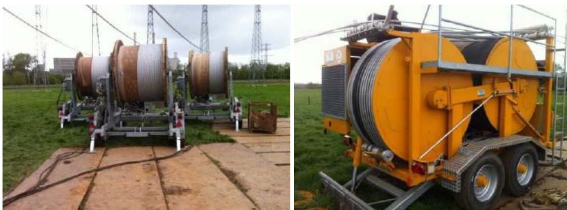
Figure 18 : Tireuse et freineuse utilisées pour la mise en place du câble
