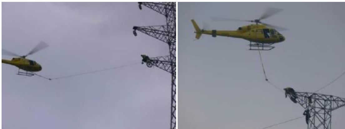
Figure 17 : Installation de la corde dans les poulies de tirage par hélicoptère (source : Etude d'incidences relative à la démolition et reconstruction de la ligne haute tension de 150 kV entre Gouy et Oisquercq, 2017)
