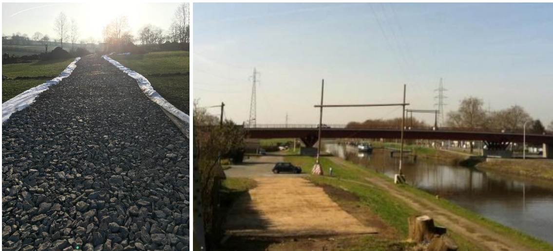
Figure 14 : Exemple d'accès en gravier (à gauche) et de portique de protection à droite (source : Elia, Etude d'incidences relative à la démolition et reconstruction de la ligne haute tension de 150 kV entre Gouy et Oisquercq, 2017)
