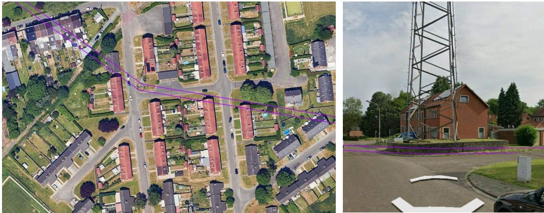
Ligne 150 kV Gouy-Trivières (Pylône 4) : L’îlot d’époque de 8 m de côté construit en arrondi en pierres de taille serait trop petit pour implanter un pylône d’angle 380 kV.
