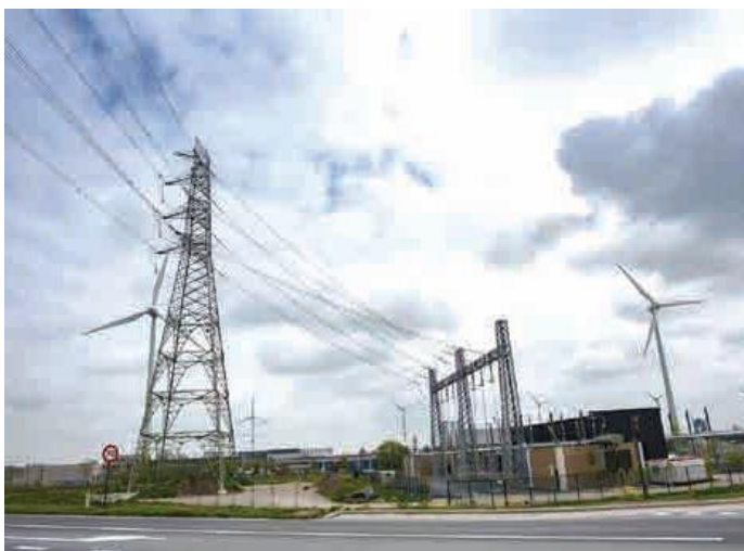
Figure 56 : Poste de transition aérien / souterrain (Source : Etude technologique, Elia, février 2019)
