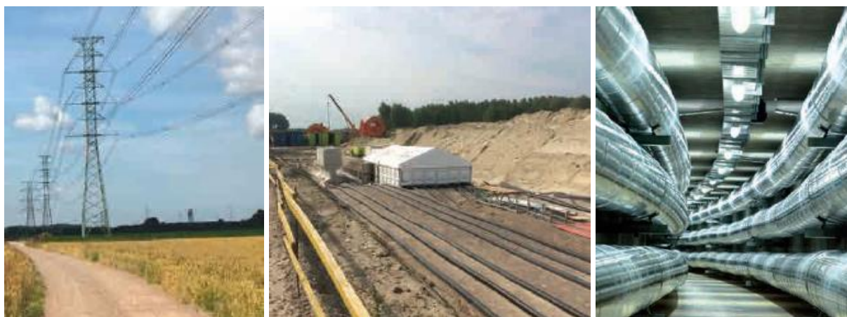
Figure 47 : Illustration des technologies de liaisons aériennes (à gauche), de câbles souterrains (au centre) et de GIL (à droite). (Source : Etude technologique, Elia, février 2019).
