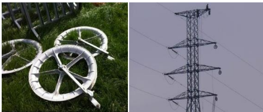
Figure 16 : Poulies de tirage (à gauche) et poulies fixées aux consoles d'un pylône (à droite) (source : Etude d'incidences relative à la démolition et reconstruction de la ligne haute tension de 150 kV entre Gouy et Oisquercq, 2017)
