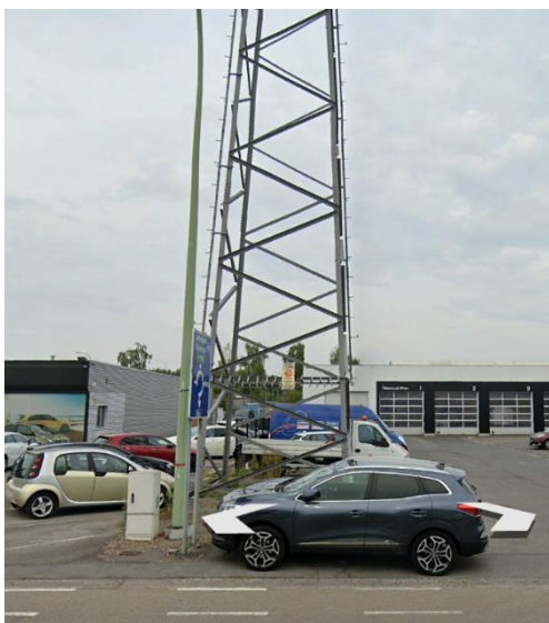
Ligne 150 kV Quaregnon-Trivières (Pylônes 15 et 16) : Pylônes inscrits en zone disposant peu d'espace pour une emprise au sol supérieure.
