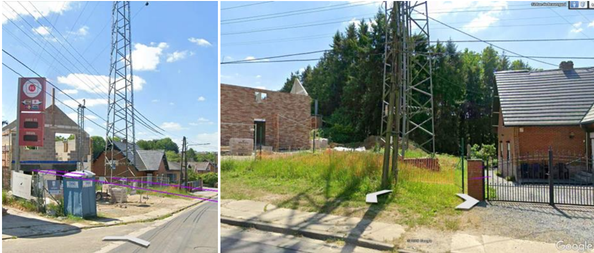
Ligne 150 kV Gouy-Trivières (Pylône 33) : Deux nouvelles constructions sont venues s’implanter de part et d’autre du pylône existant engendrant un manque d’espace pour implanter un pylône 380 kV en lieu et place.
