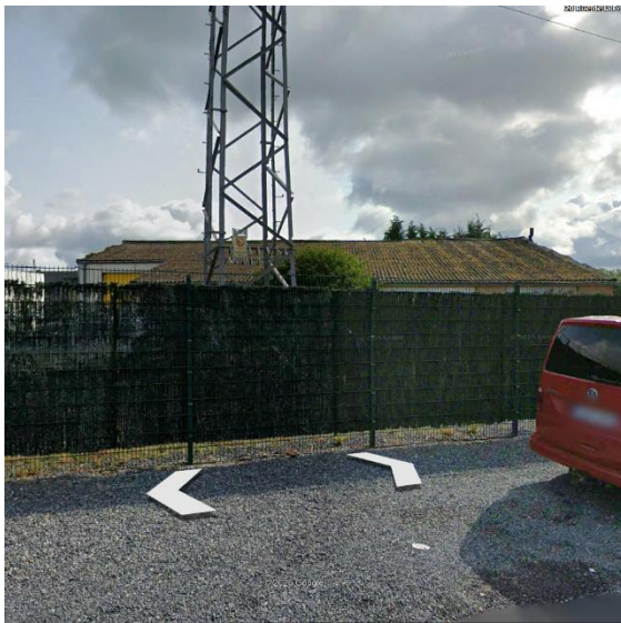
Ligne 150 kV Quaregnon-Trivières (Pylônes 15 et 16) : Pylônes inscrits en zone disposant peu d'espace pour une emprise au sol supérieure.
